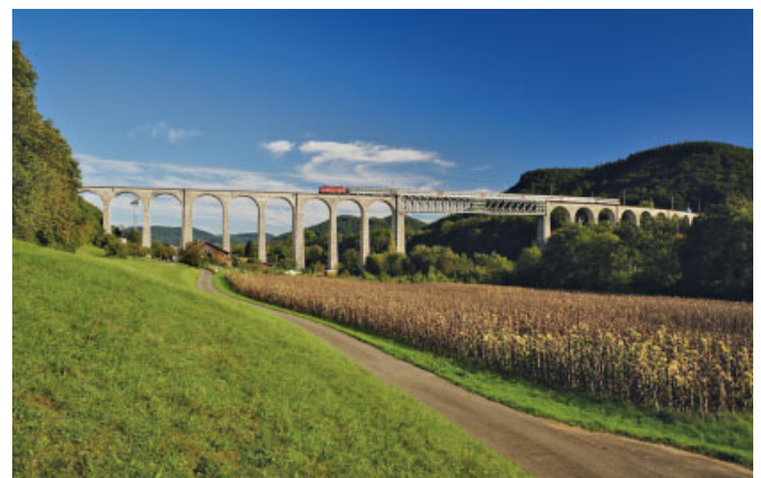
Bild 1. Gesamtansicht der Eisenbahnbrücke Eglisau inklusive der Vorlandbrücken und Stahlfachwerk Fig. 1. Overall view of the Eglisau Railway Bridge
