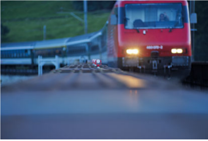
Bild 12. Freie Fahrt auf der Rheinbrücke Eglisau dank messtechnischer Überwachung
