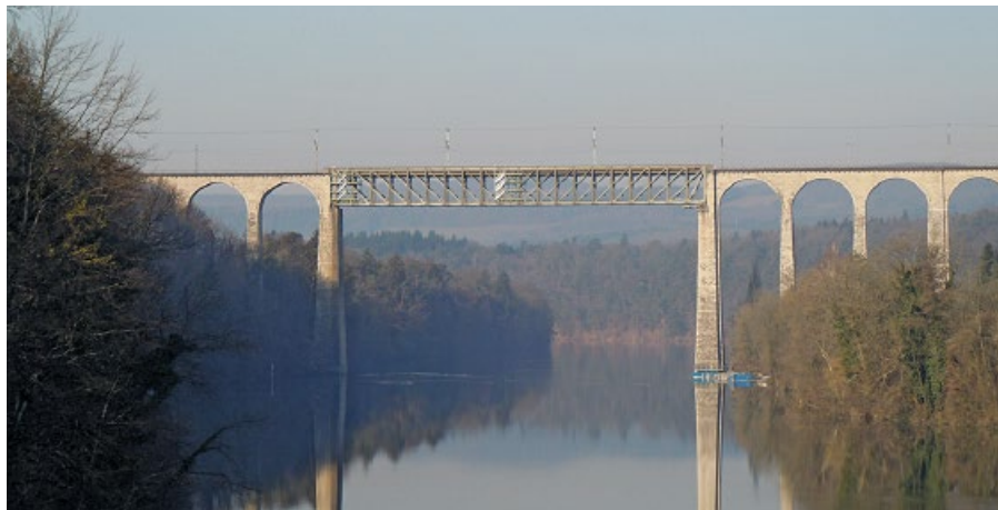
Bild 1. Bahnbrücke über den Rhein bei Eglisau, Schweiz (Foto: privat) Fig. 1. Railway bridge over the Rhine at Eglisau, Switzerland
