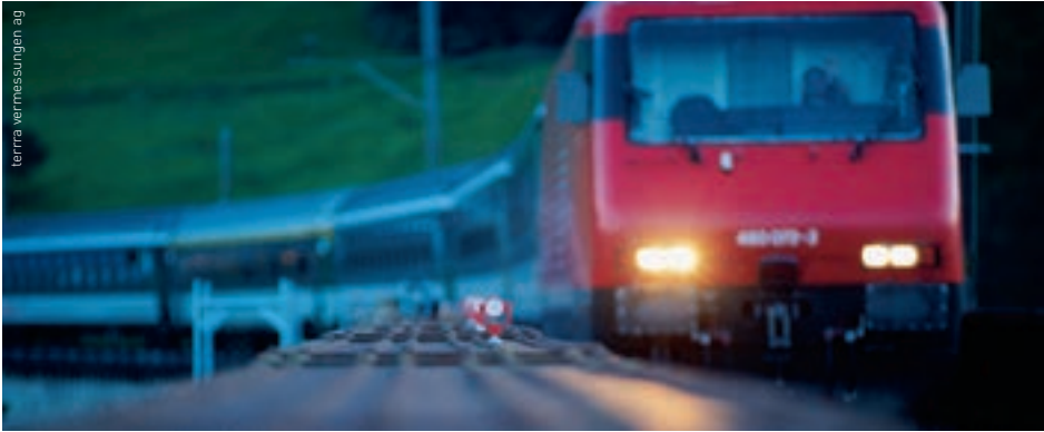
129 Dehnungsmessgeber erfassen die Daten, sobald ein Zug auf die Brücke fährt.
